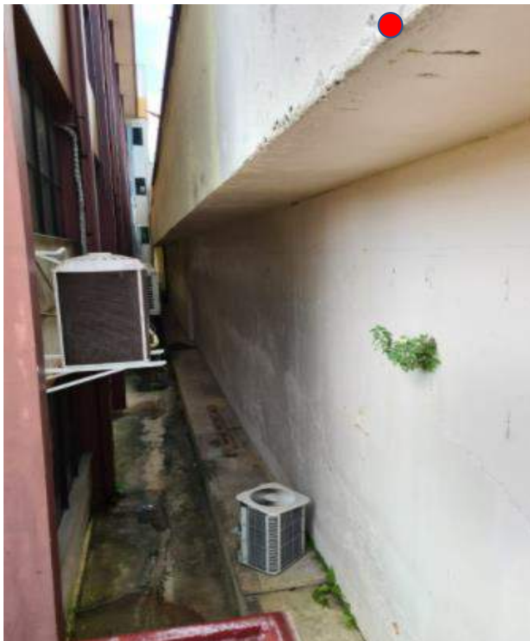
14 – Corredor entre o prédio administrativo e o estacionamento de carros funcionais
