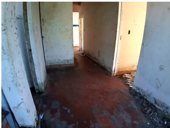
Imagem 15: Circulação da edificação - corredor.
