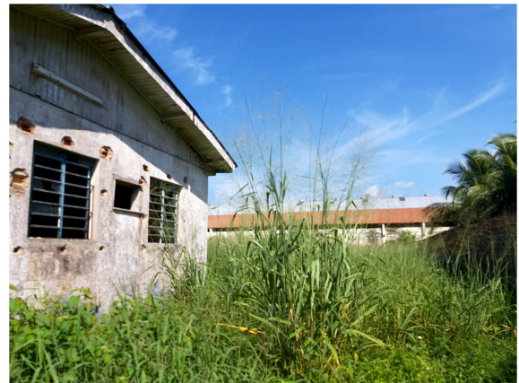
Imagem 4: Vista da Lateral direita da edificação do Terreno, limitante com o muro da Escola Municipal Santina Prado de Negreiros.
