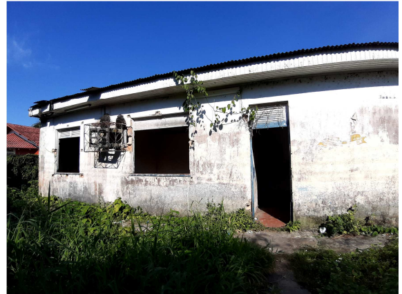
Imagem 2: Fachada da edificação do MP/AM da Comarca de Maués.
