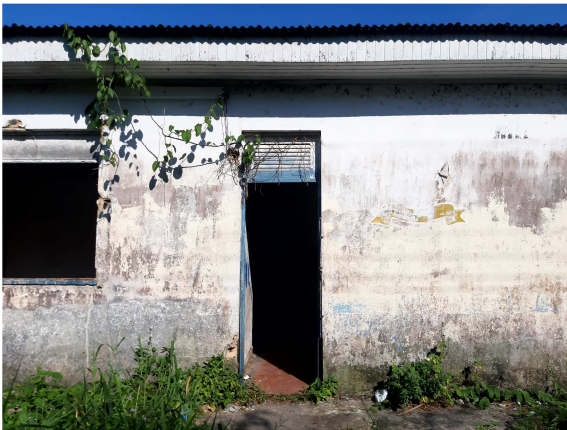
Imagem 7: Porta de entrada da Edificação.
