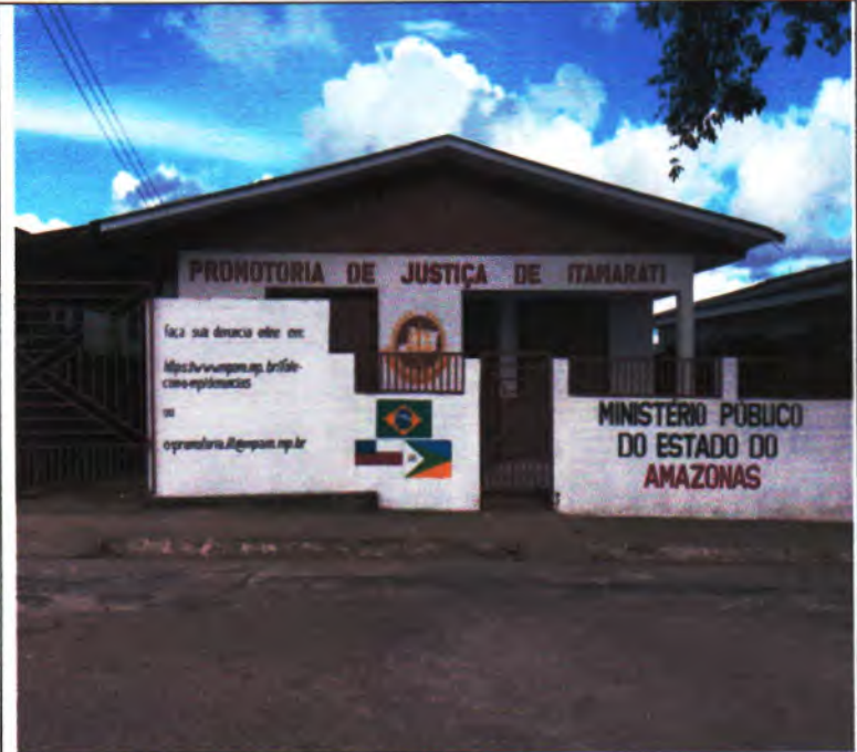
Figura 2. Fachada Frontal do Terreno.
