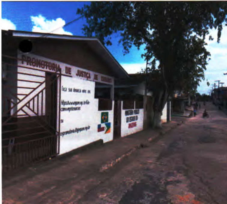
Figura 1. Fachada Frontal do terreno e rua 13° de maio.
