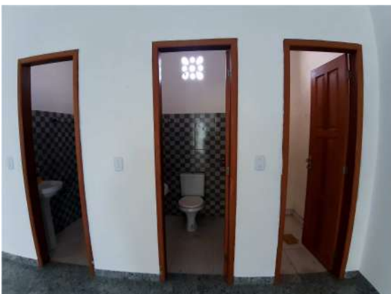
Imagem 17: IMÓVEL 3 – Banheiro feminino, banheiro masculino e depósito.
