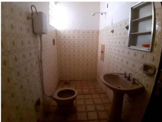
Imagem 29: IMÓVEL 6 – Pavimento Térreo – Banheiro social.
