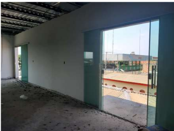
Imagem 11: IMÓVEL 2 – Esquadrias de vidro.
