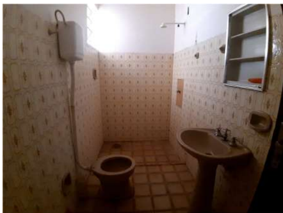
Imagem 29: IMÓVEL 6 – Pavimento Térreo – Banheiro social.
