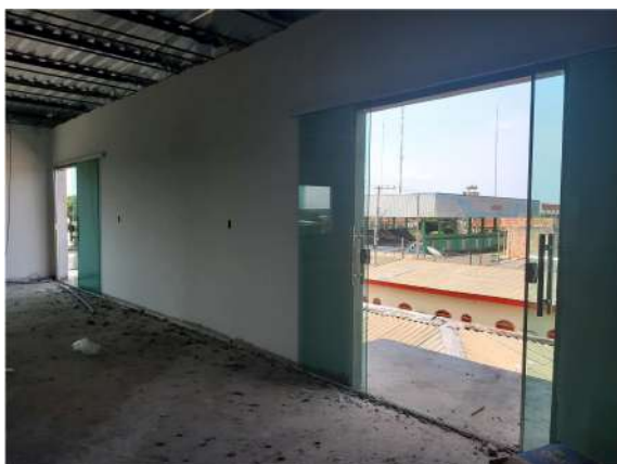
Imagem 11: IMÓVEL 2 – Esquadrias de vidro.
