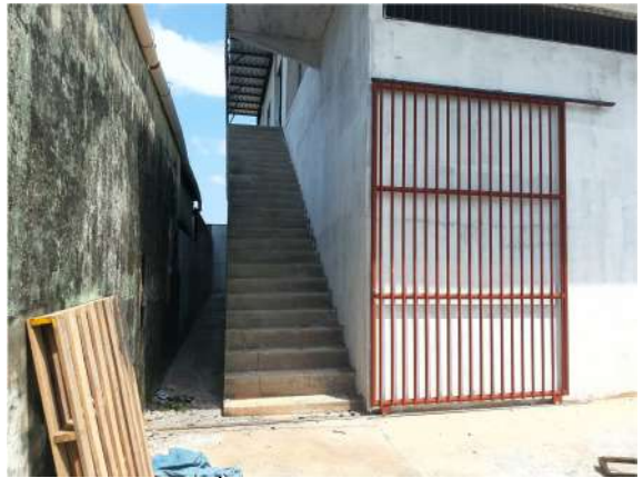
Imagem 8: IMÓVEL 2 – Escada de acesso ao pavimento superior.
