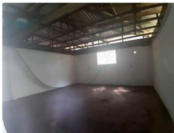
Imagem 26: IMÓVEL 6 – Andar superior, com salas inacabadas.
