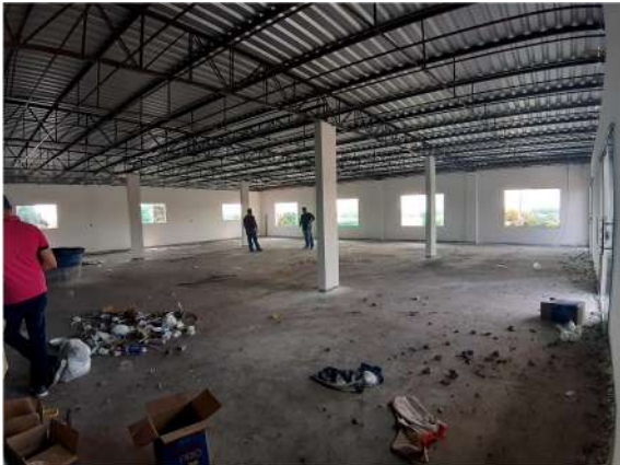
Imagem 9: IMÓVEL 2 – Salão com obras de acabamento (em andamento) .
