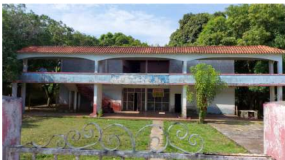
Imagem 23: IMÓVEL 6 – Misto (residencial e comercial), localizado na Av. Pedro de Moura, N° 824, Bairro Terra Preta. Estado de conservação péssimo, com instalações precárias.
