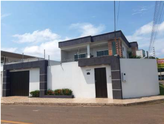
Imagem 31: IMÓVEL 7 – Imóvel Residencial, localizado na Rua Carauari esquina com Rua Itacoatiara, Nº 1307, Bairro União.
