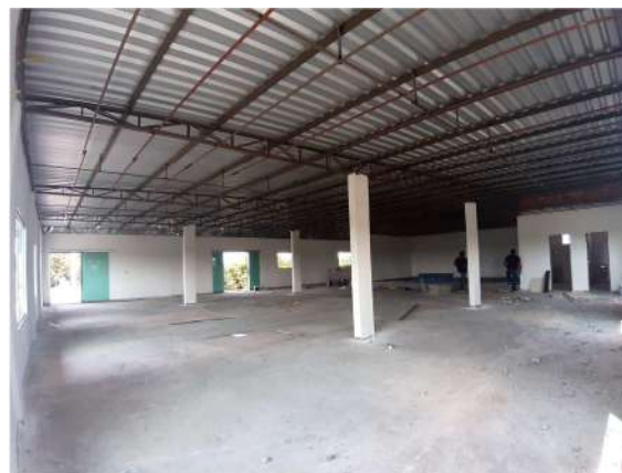
Imagem 10: IMÓVEL 2 – Salão com obras de acabamento (em andamento).
