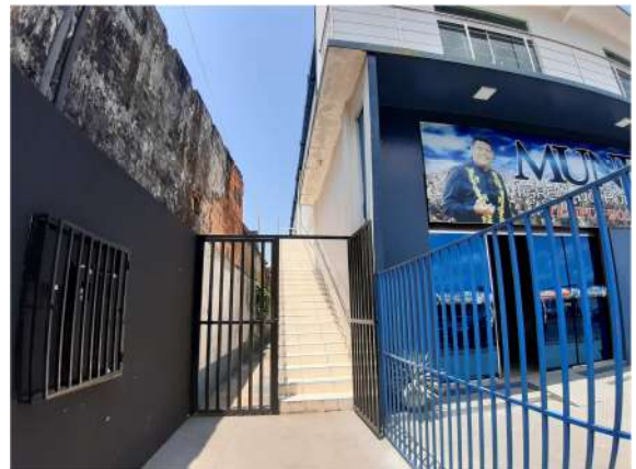
Imagem 14: IMÓVEL 3 – Galpão, com portão e escada de acesso ao pavimento superior. Imóvel não disponibiliza estacionamento.
