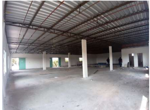
Imagem 10: IMÓVEL 2 – Salão com obras de acabamento (em andamento).
