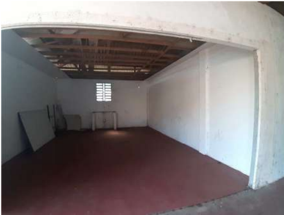
Imagem 25: IMÓVEL 6 – Andar superior, com acesso por escada externa, com 5 salas inacabadas.
