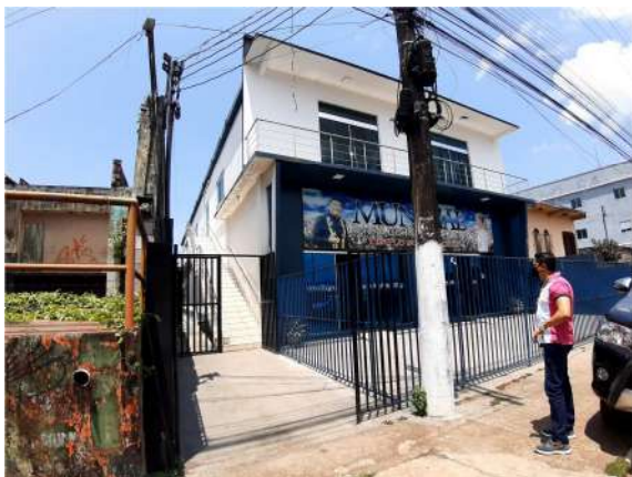
Imagem 13: IMÓVEL 3 – Fachada. Localizado na Av. Manoel Urbano, Centro, próximo à Agência dos Correios.
