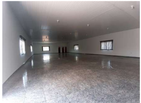
Imagem 16: IMÓVEL 3 – Salão, piso cerâmico, esquadrias de vidro, fôrro PVC.
