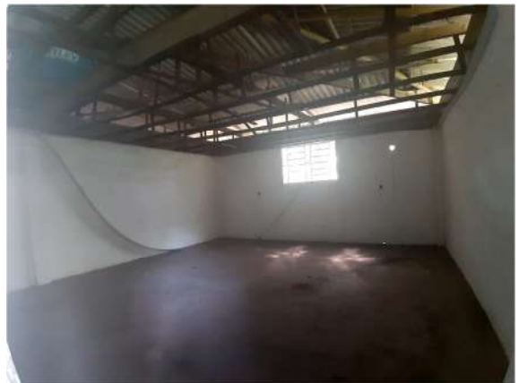
Imagem 26: IMÓVEL 6 – Andar superior, com salas inacabadas.
