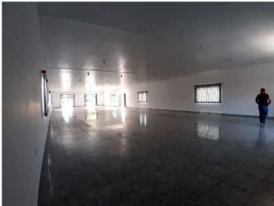
Imagem 15: IMÓVEL 3 – Salão, piso cerâmico, esquadrias de vidro, fôrro PVC.
